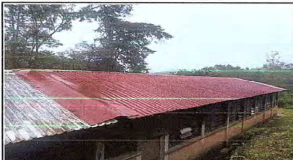
Foto 1: CUBIERTA DE LÁMINA
