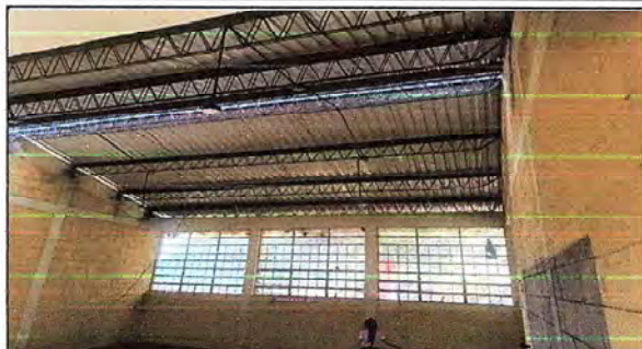
Foto 2: ESTRUCTURA DE TECHO
