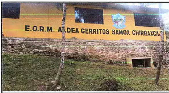
Foto 5: PINTURA EN MUROS INTERIOR Y EXTERIOR
